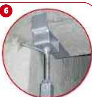
Blocage de la baie avec équerre à vis
